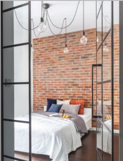
montaż cegły dekoracyjnej
