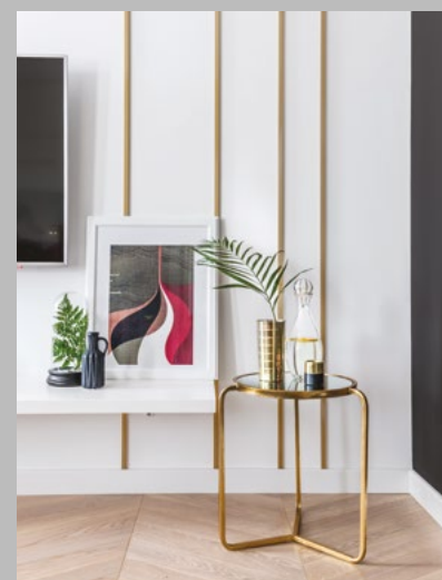
montaż elementów dekoracyjnych
